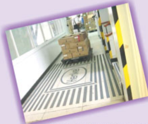
汉高公司仓库楼梯口等地的地面防滑处理
