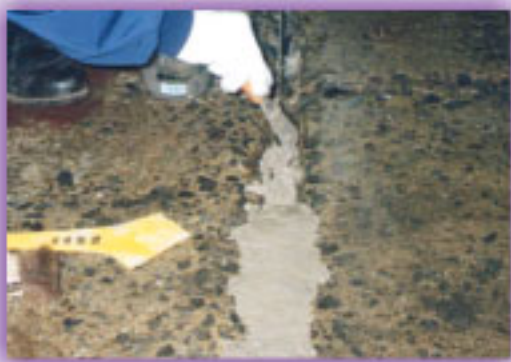
修补地面裂缝，配合牢固，方便车辆行驶
